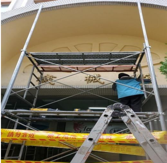
1-2 機械大樓地震災損外牆拉皮
